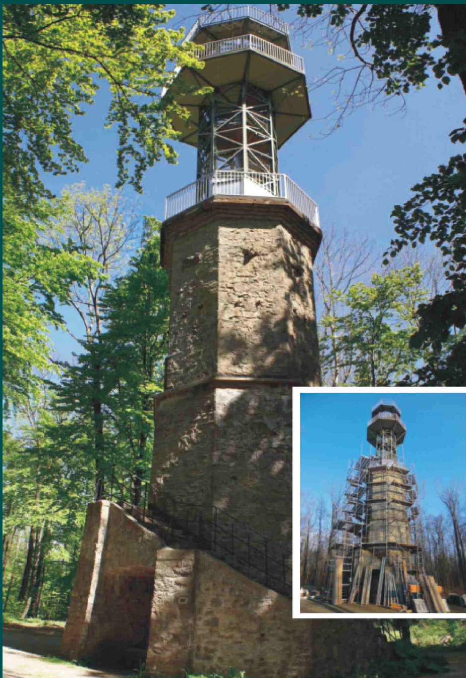
Der Löns-Turm im Weserbergland wurde für 125 912 Euro saniert. 37 773 Euro kamen als Fördergeld von der Europäischen Union.
